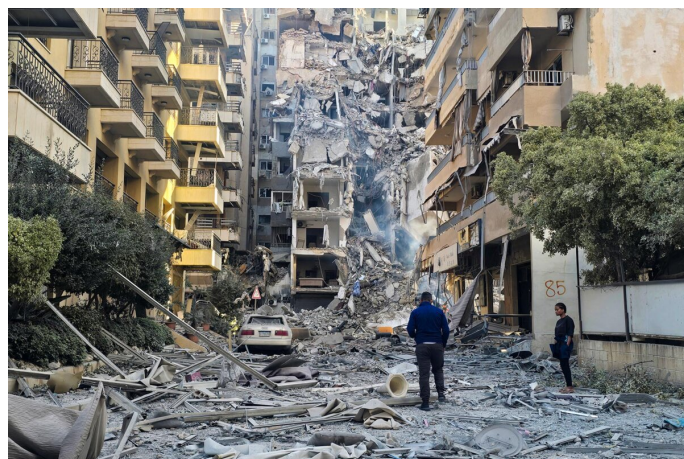
Des personnes examinent les dégâts sur le site d'une frappe israélienne à Tyr, dans le sud du Liban, le 28 mai 2026. © Photo Kawnat Haju / AFP
