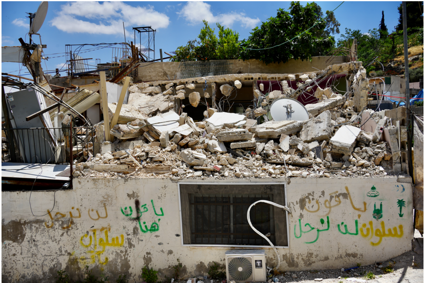
Sur une maison démolie, la mention dessinée deux fois : « Nous restons. Nous ne partons pas. » Jérusalem-Est, 16 mai 2026. © Photo : Rachida El Azzouzi / Mediapart
